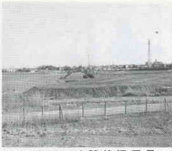
運動公園建設状況風景
